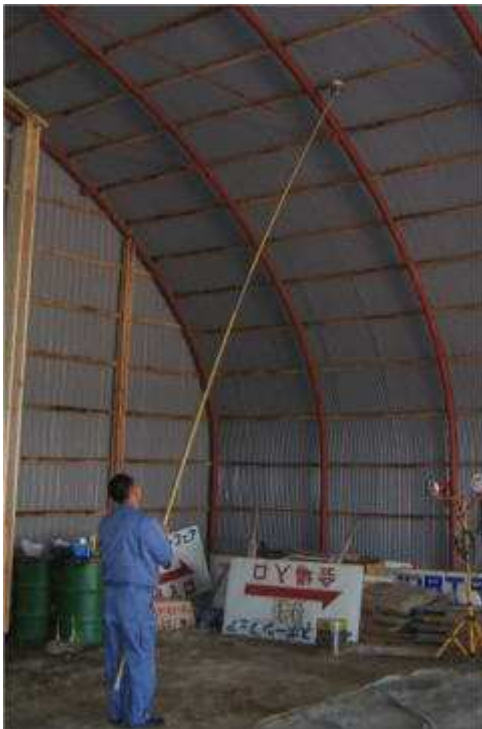
センサーに熱源を近づけて作動試験中。
